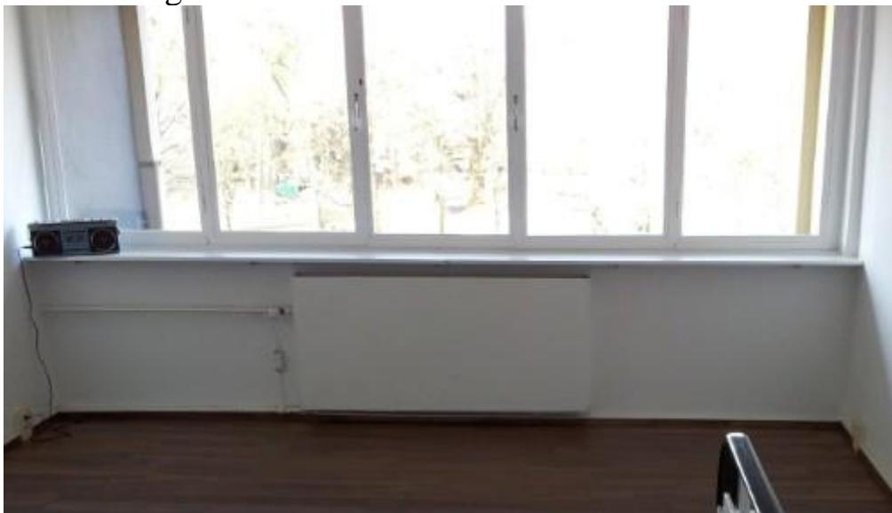
Veränderungen an den Verkleidungen schmälern die Heizleistung! Auch zu beachten ist, dass sich die feingliedrigen Lamellen der Konvektoren schnell mit Staub zusetzen. Daher ist eine Reinigung zweimal im Jahr anzuraten und sehr empfehlenswert. (Ein Staubsauger hilft)
